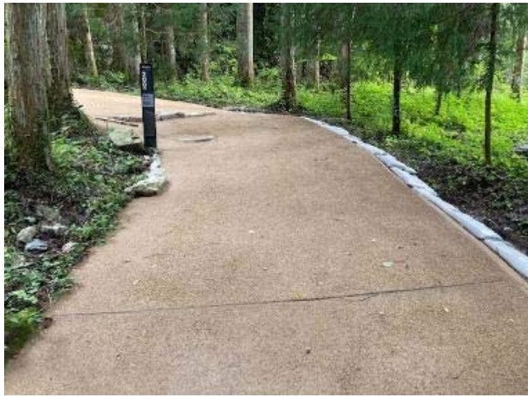
三重櫓付近の舗装工事
