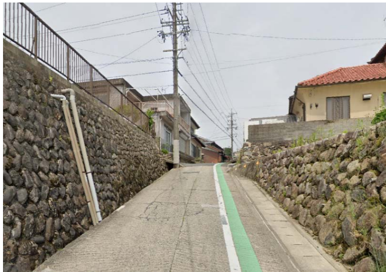
対象道路(市道大井町232号線)
