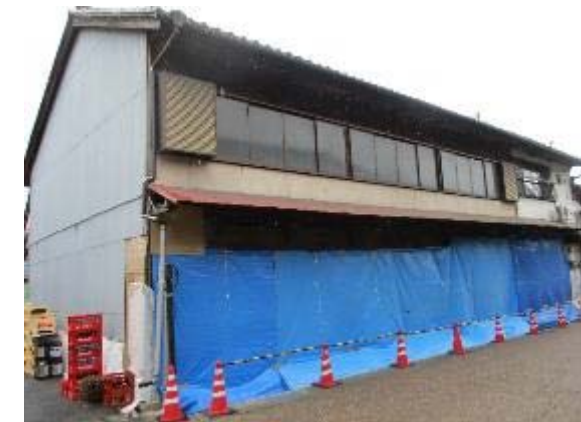
修理事例(修理中)
