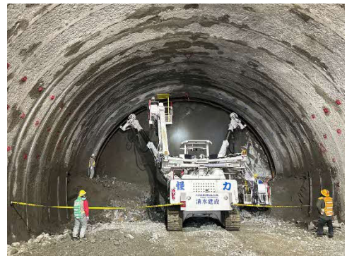
トンネル内施工状況
