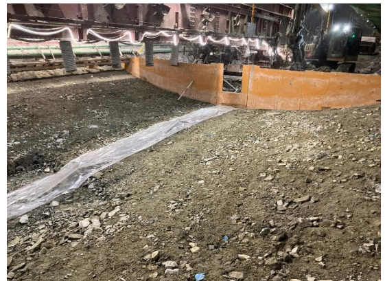
インバート工作業状況 （掘削完了状況）
