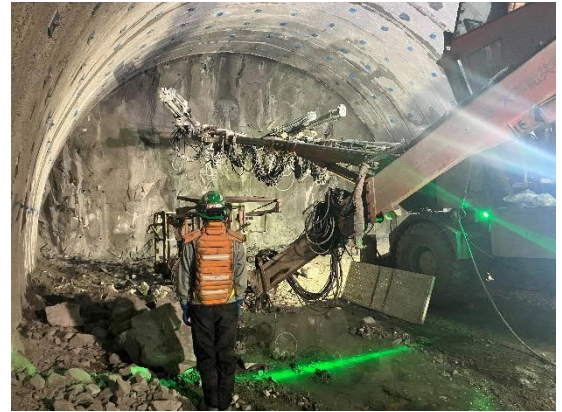
トンネル掘削作業状況 （削孔状況）
