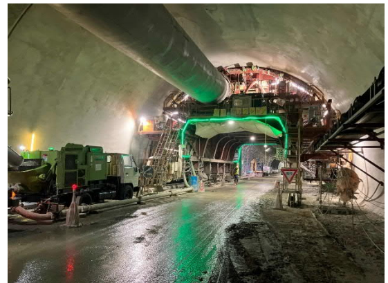
覆工コンクリート工作業状況 （コンクリート打設状況）
