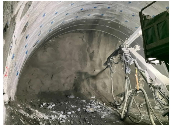
トンネル掘削作業状況 （吹付状況）
