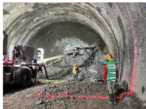
トンネル施工状況
