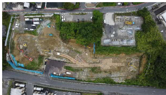
大井非常口ヤード全景（写真）
