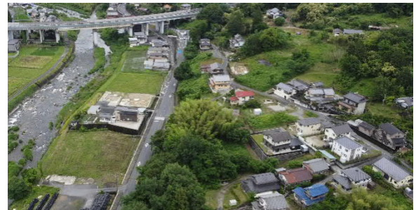
市道 01171 号線道路付替え工事ヤード 全景（写真）
