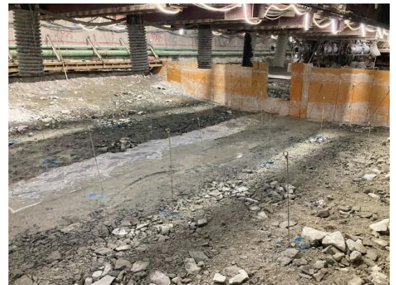
インバートコンクリート工作業状況 （掘削完了）
