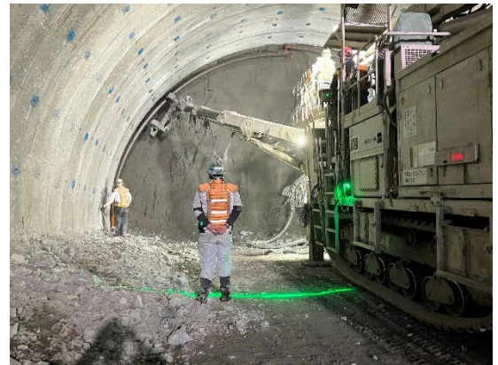
トンネル掘削作業状況 （支保工建込状況）
