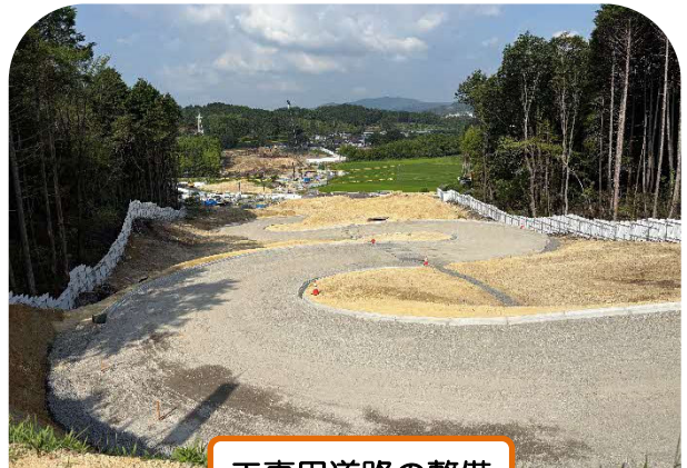
工事用道路の整備
