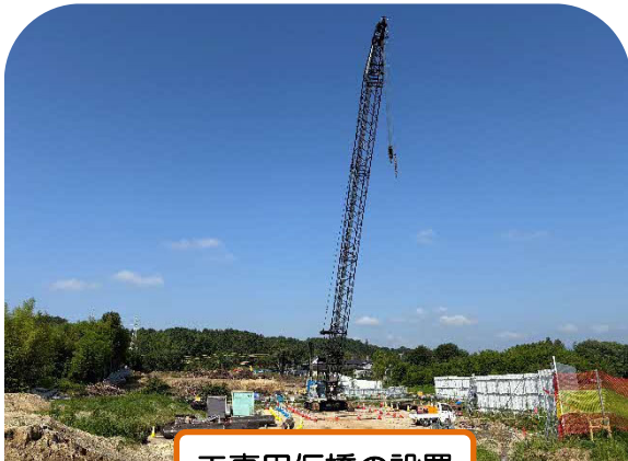
工事用仮橋の設置
