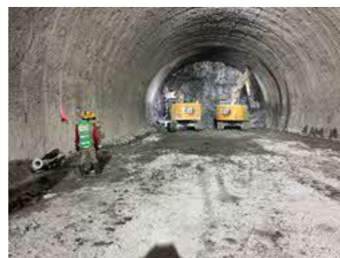
トンネル施工状況
