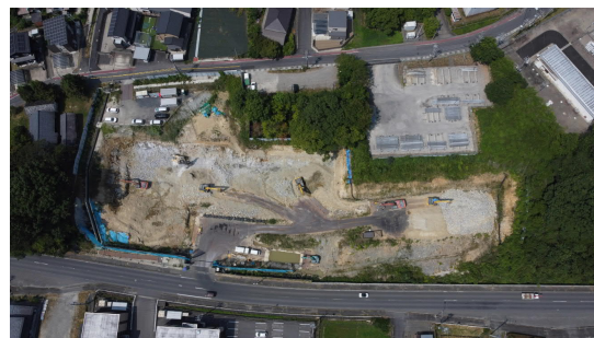
大井非常口ヤード全景（写真）
