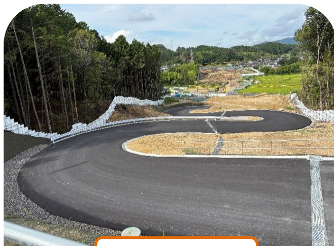
工事用道路の整備
