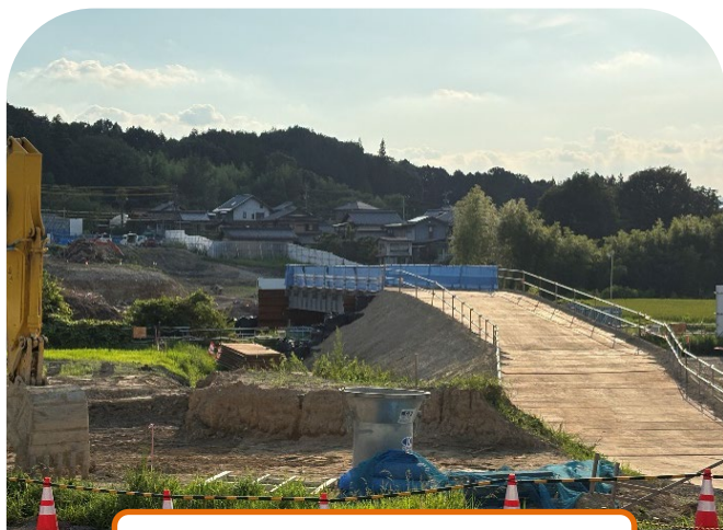
工事用仮橋と道路盛土の整備
