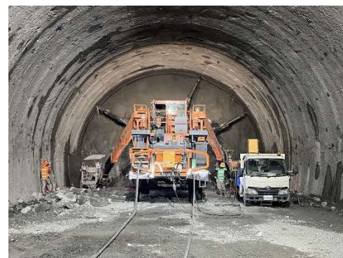
トンネル施工状況
