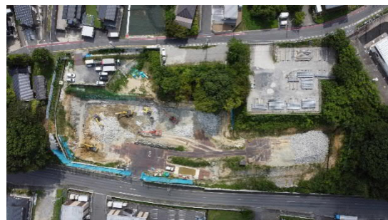
大井非常口ヤード全景（写真）
