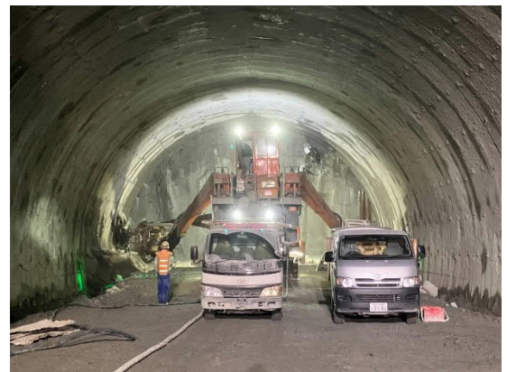
トンネル掘削作業状況 （装薬孔削孔状況）
