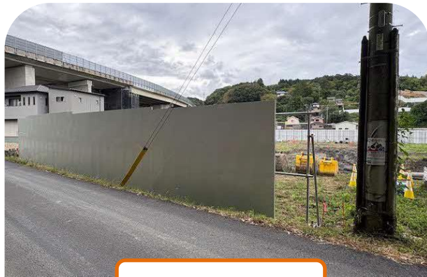
仮囲いの設置
