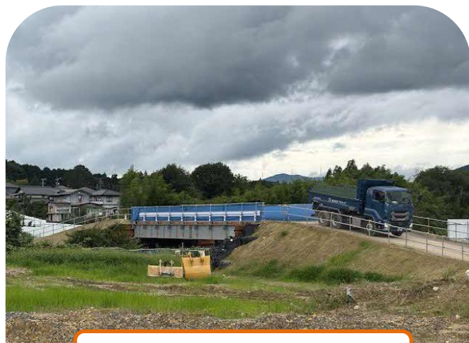
工事用仮橋と道路盛土の整備
