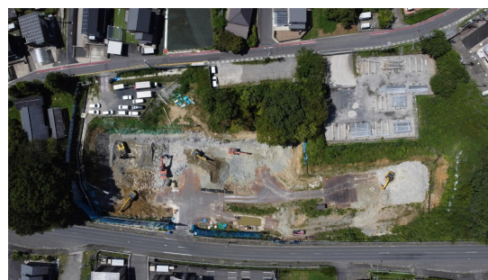
大井非常口ヤード全景（写真）
