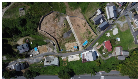
市道 01171 号線道路付替え工事ヤード 全景（写真）
