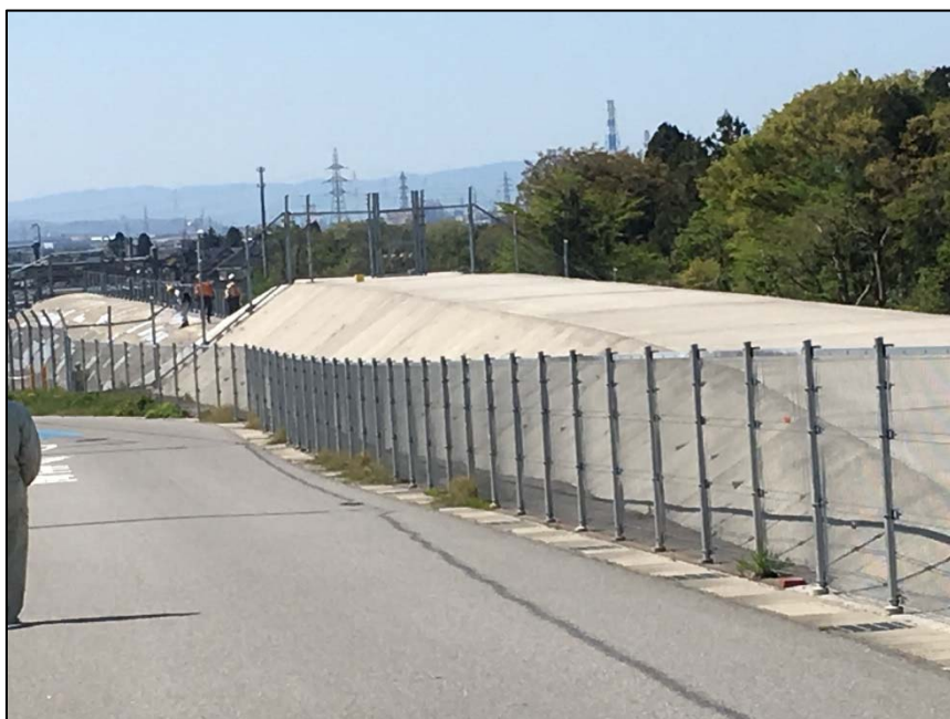
北陸新幹線 類似工法箇所（富山市北代地区）
