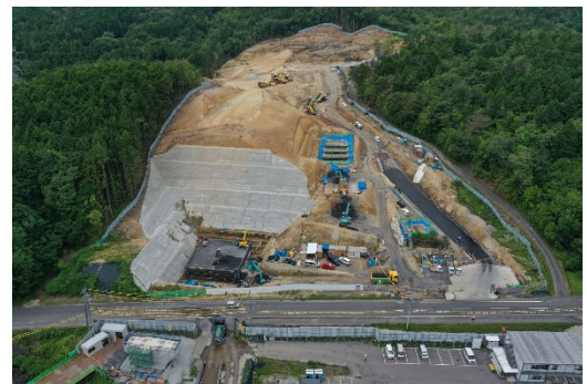
ヤード整備工
