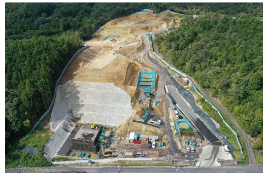
ヤード整備工
