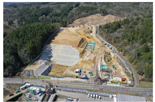
ヤード整備工
