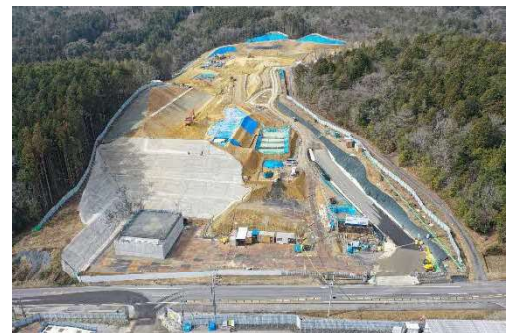
ヤード整備工
