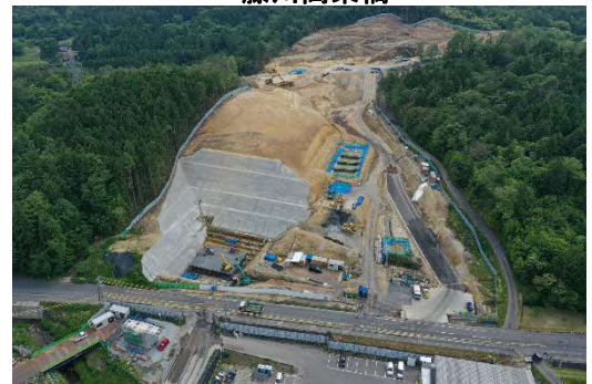
ヤード整備工
