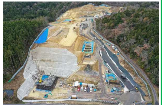
ヤード整備工
