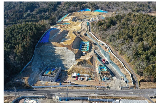
ヤード整備工
