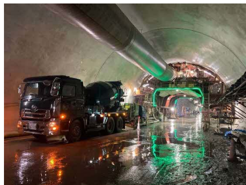
覆工コンクリート作業状況 （コンクリート打設状況）
