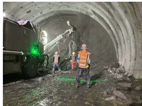
トンネル掘削作業状況 （吹付コンクリート状況）
