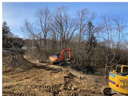
伐採作業状況
