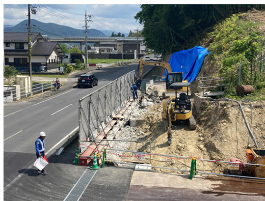
県道側擁壁取壊し状況
