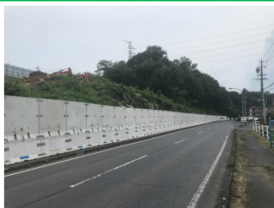
仮設落石防護柵設置完了
