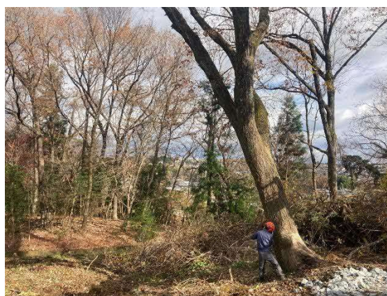
伐採作業状況
