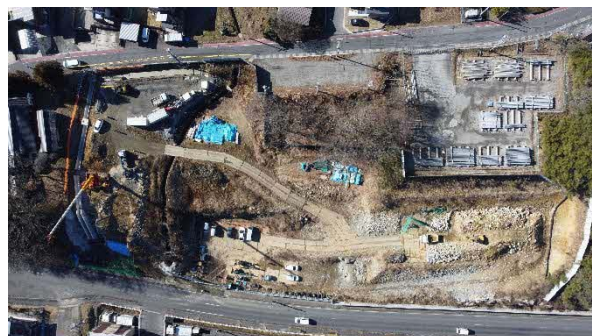
大井非常口ヤード全景
