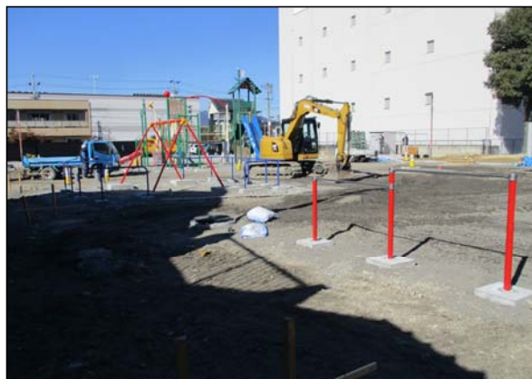
改修工事の様子
