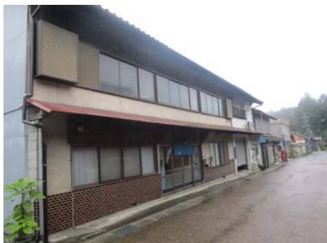
修理事例(修理前)
