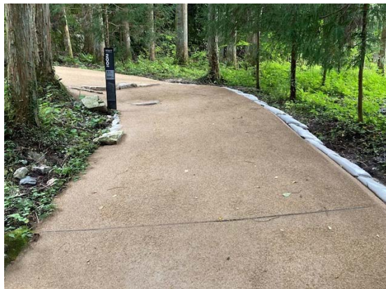
三重檜付近の舗装工事
