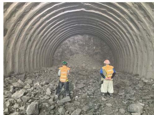
トンネル掘削作業状況 （発破後確認状況）
