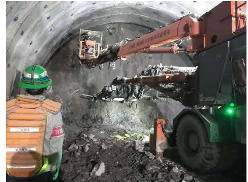
坑内作業状況（装薬）
