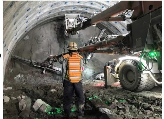
トンネル掘削状況
