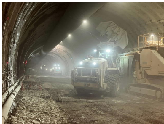
トンネル掘削作業状況（すり出し）
