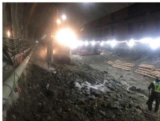
インバート掘削状況
