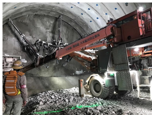
トンネル工事施工状況
