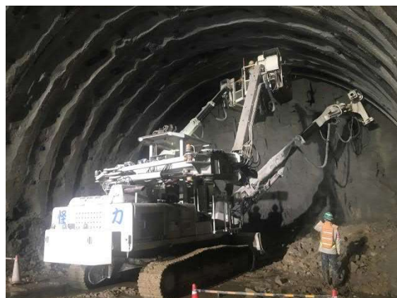
坑内作業状況（支保工建込）
