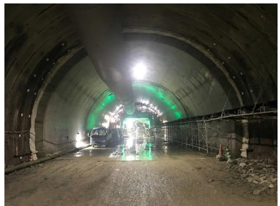
覆工コンクリート打設完了区間
