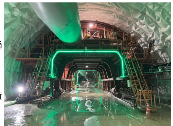
覆工用型枠（セントル）
