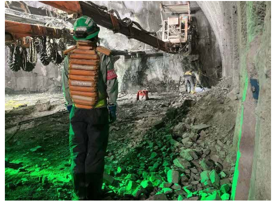
トンネル掘削作業状況
