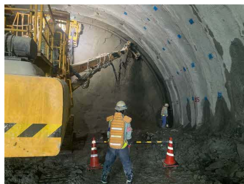
トンネル掘削作業状況
