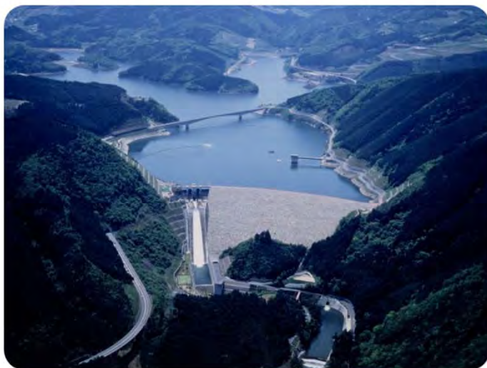
阿木川ダム（提供：独立行政法人水資源機構阿木川ダム管理所）
