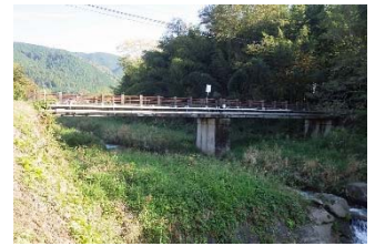
【図1】橋りょう修繕
