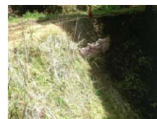
林道 木根中島線修繕工事
