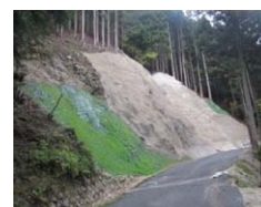
林道 暗沢線改良工事
