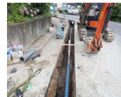
配水管布設替工事
