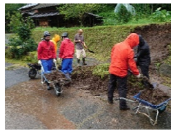
R 3年8月豪雨災害（土砂撤去）
