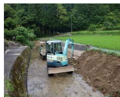
普通河川の浚渫状況
