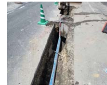
配水管布設替工事
