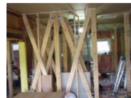
木造住宅耐震補強工事
