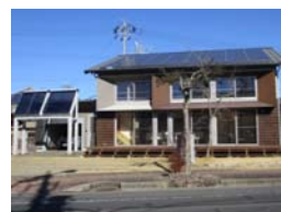
太陽光発電システムと太陽熱温水システムを備えた住宅
