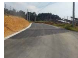
整備が進む飯地町68号線
