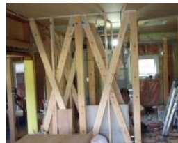
木造住宅耐震補強工事
