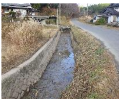
浚渫が完了した山岡町の大坪川
