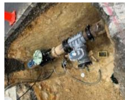
配水管の耐震化
