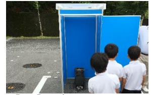
【図5】災害用マンホールトイレ
