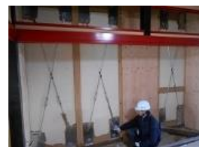
【図3】耐震補強工事の様子
