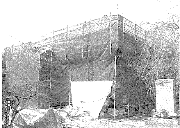
H27工事後 北東面
