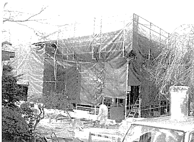
H27工事前 北東面
