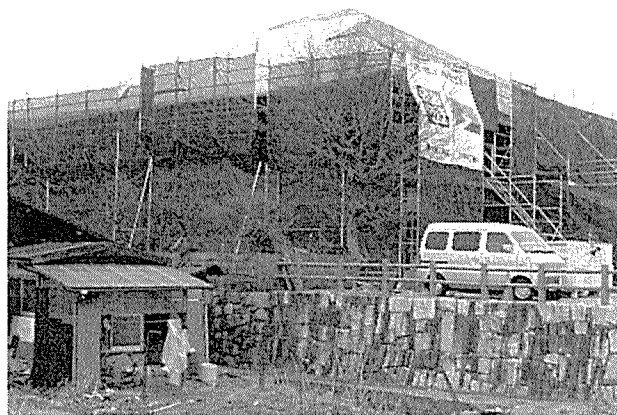
H27工事前 南西面
