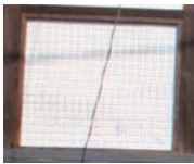
金属板張り仕上 タイルを模した鋼板仕上
