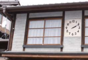
モルタル刷毛引き仕上
