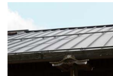
カラ-鋼板瓦棒葺きと雪止め
