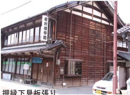
押縁下見板張り
