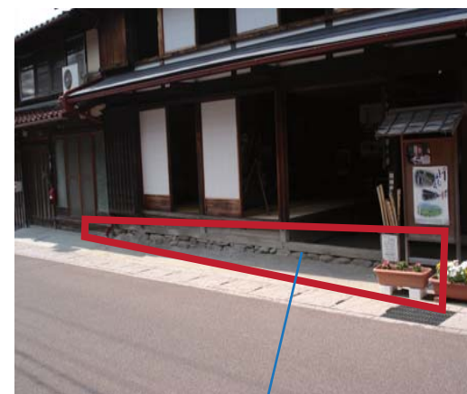
土台下に御影石の 自然石を用いている
