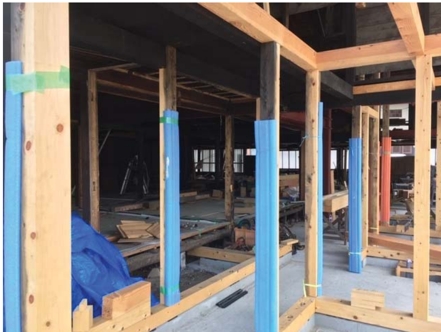
内部補強の様子
