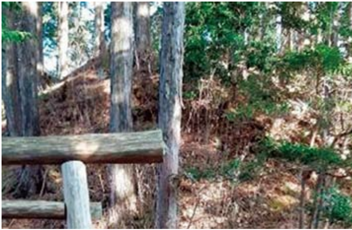
主郭南東斜面の切岸
