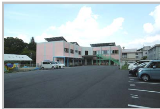
▲センターの外観
