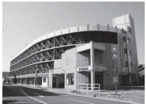
改修工事を行う恵那駅西駐車場
