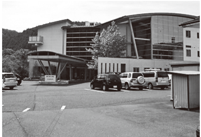
改修工事予定の恵那市介護老人保健施設ひまわり(明智町)
