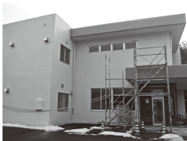
改修工事中の三郷コミュニティセンター
