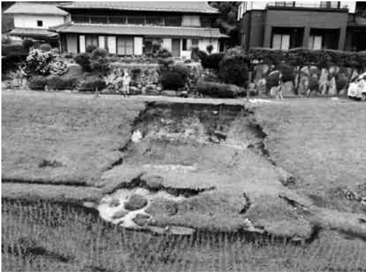
大雨による災害復旧箇所(市道山岡町216号線)
