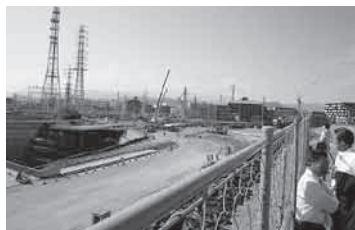
リニア神奈川駅(仮称)建設現場
