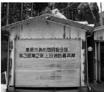
譲渡が決まった上田消防器具庫
