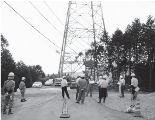
高圧送電線鉄塔建設現場での視察
