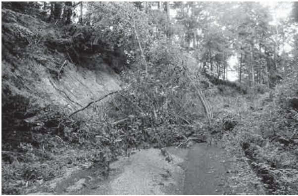
▲法面が崩壊した林道松本線（飯地町）
