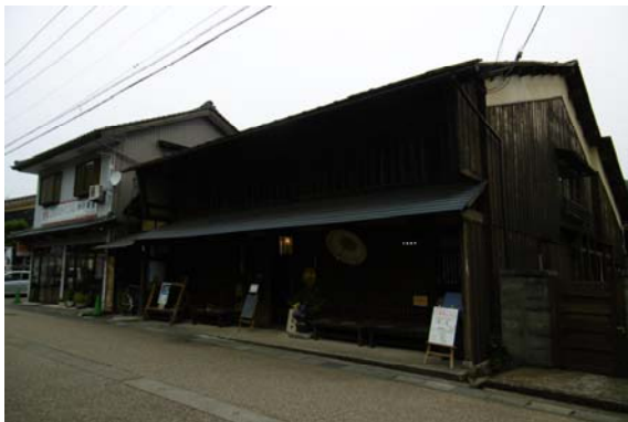
改修された旧旅籠「若狭屋」
