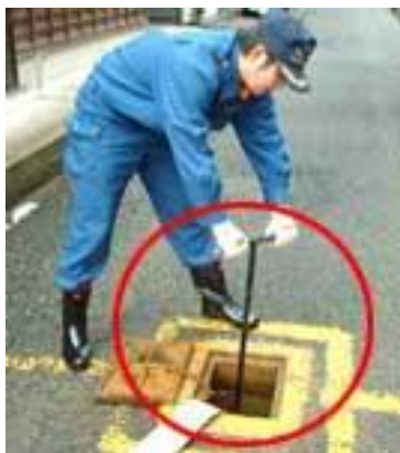
地下式消火栓
